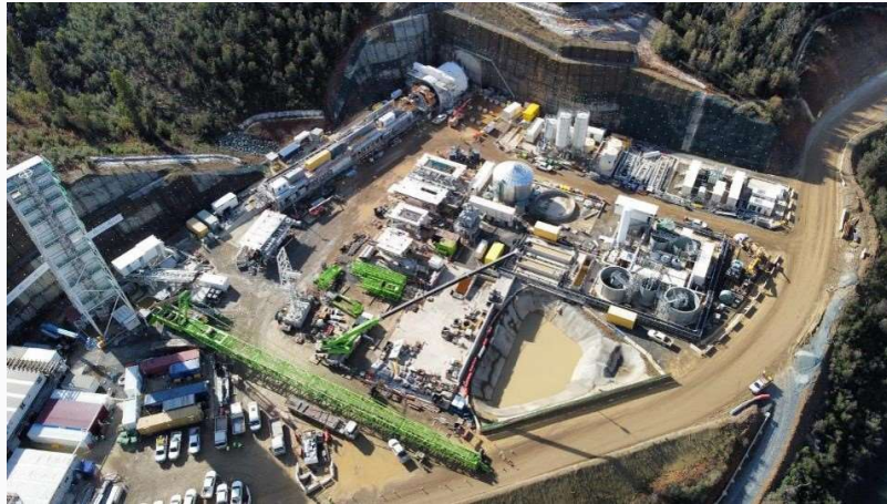
Vista dall'alto del cantiere del progetto Snowy 2.0
