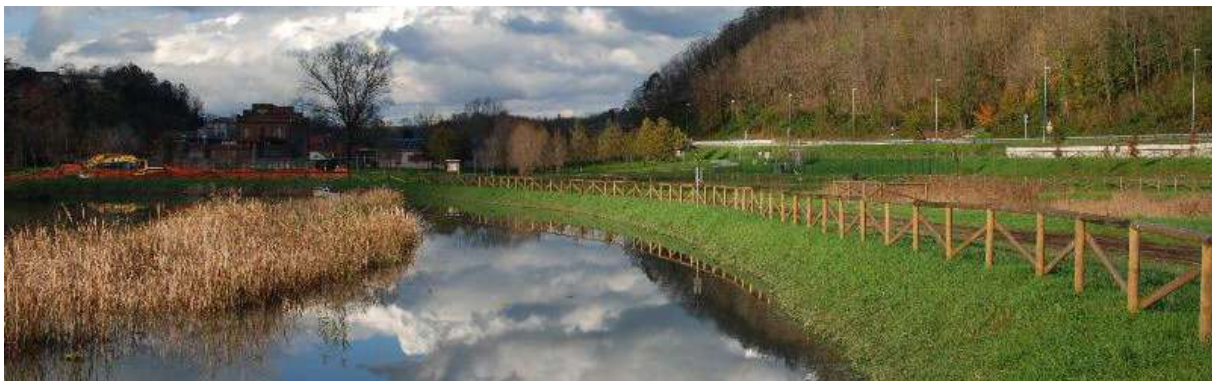
Il Parco dell'acqua tra Gorla e Fagnano, fitodepurazione
