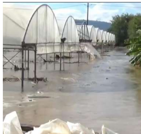
15 ottobre 2018 | Esondazione del torrente Turrina e danni alle aziende agricole
