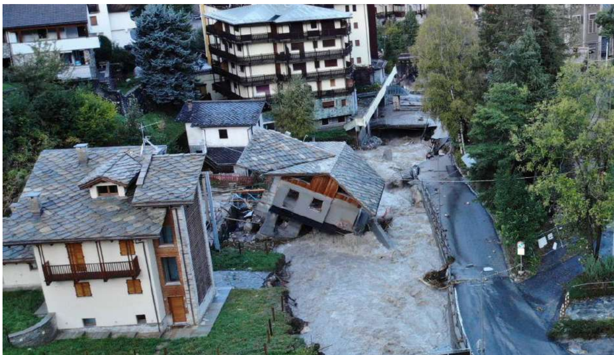
3 ottobre 2020 | Alluvione a Limone Piemonte (CN) con danni ad abitazioni ed interruzioni di strade
